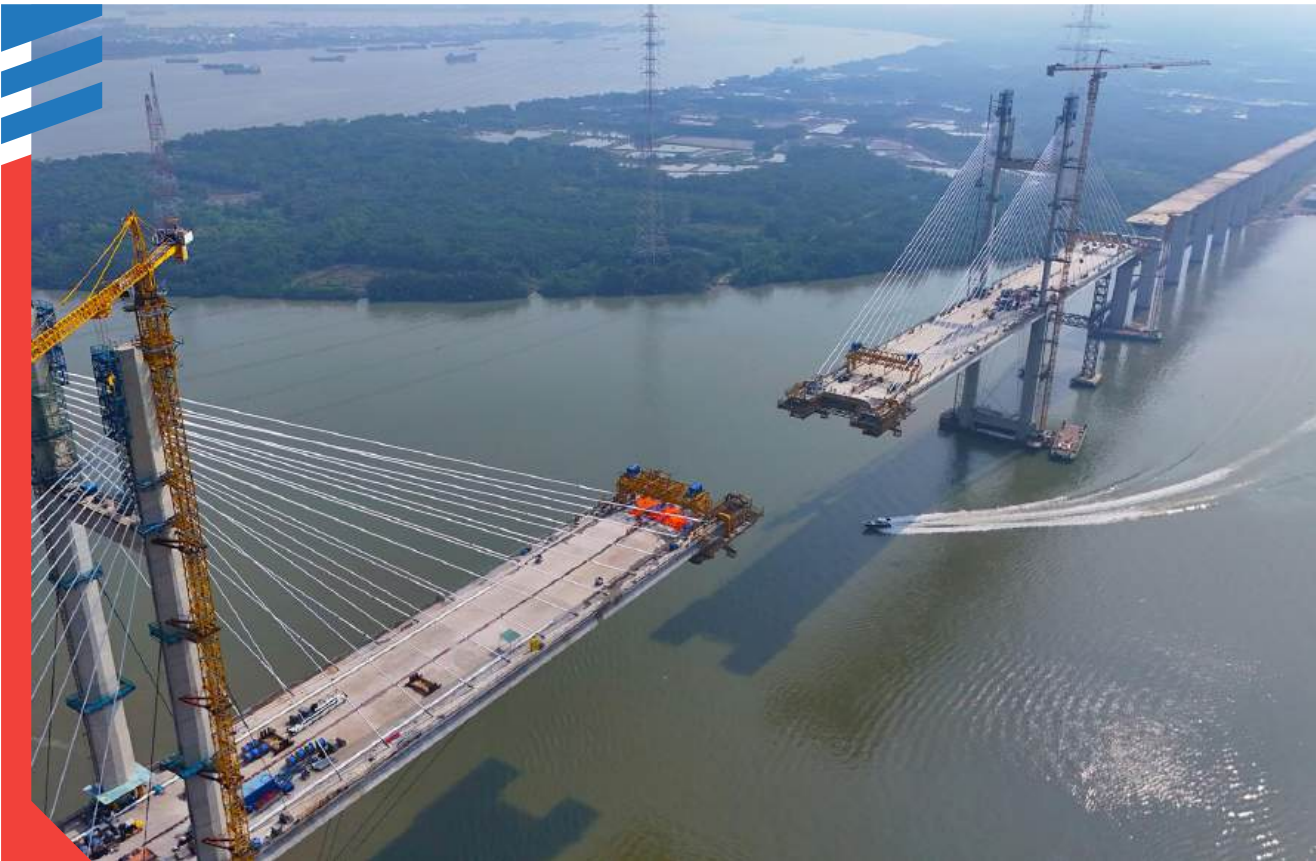
CẦU BÌNH KHÁNH - NHÀ BÈ BINH KHANH BRIDGE - NHA BE
