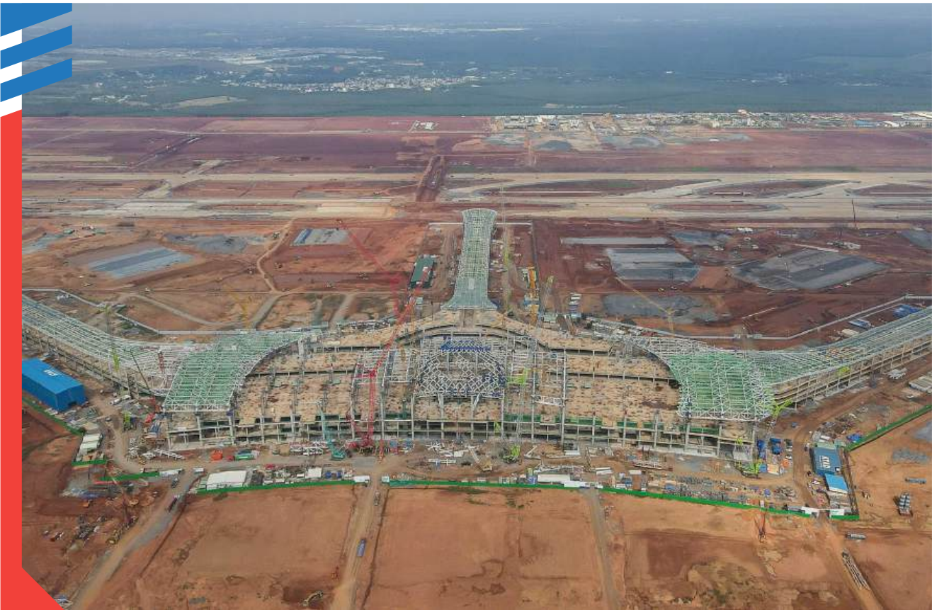
SÂN BAY LONG THÀNH LONG THANH INTERNATIONAL AIRPORT
