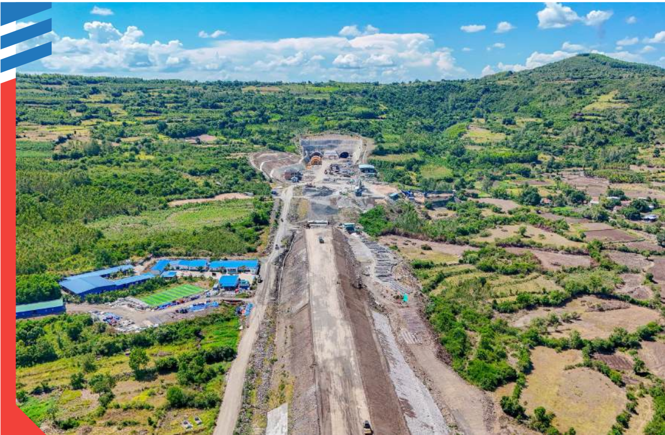
CAO TỐC VÂN PHONG - CHÍ THẠNH VAN PHONG - CHI THANH EXPRESSWAY
