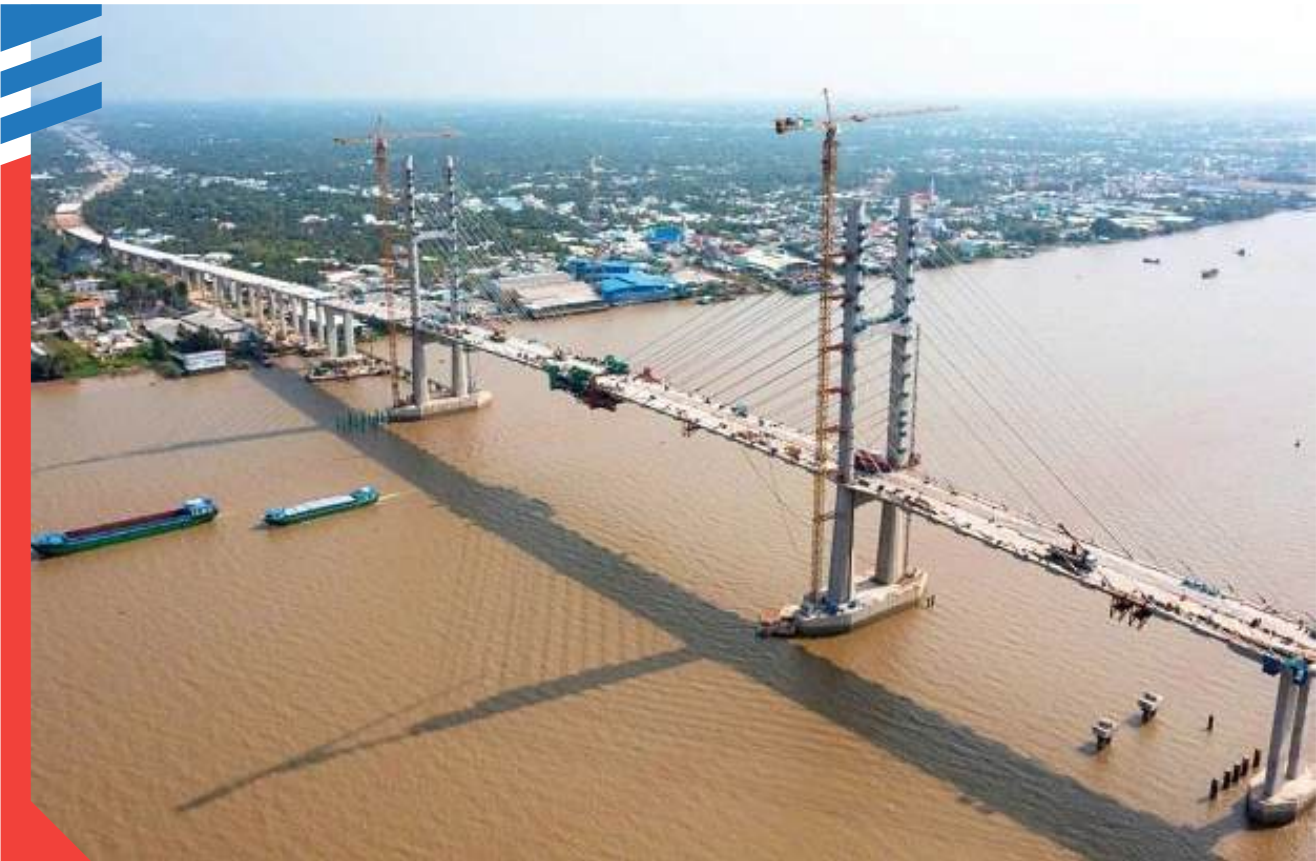
CẦU RẠCH MIẾU 2 RACH MIEU BRIDGE 2
