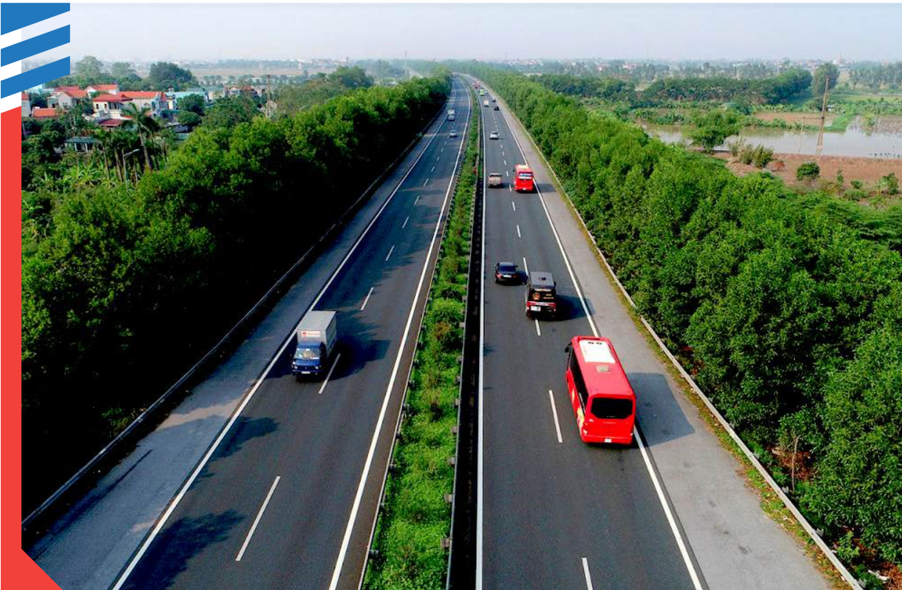
CAO TỐC CHÂU ĐỐC - CẦN THƠ - SÓC TRĂNG CHAU DOC - CAN THO - SOC TRANG EXPRESSWAY
